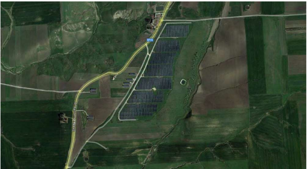
Figura 20 - Stato attuale del sito di Monreale
