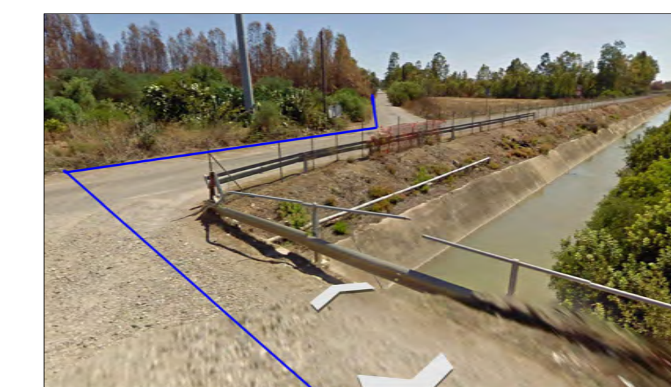
Interferenza idrica n.1 Canale ripartitore Nord-Ovest in CLS
