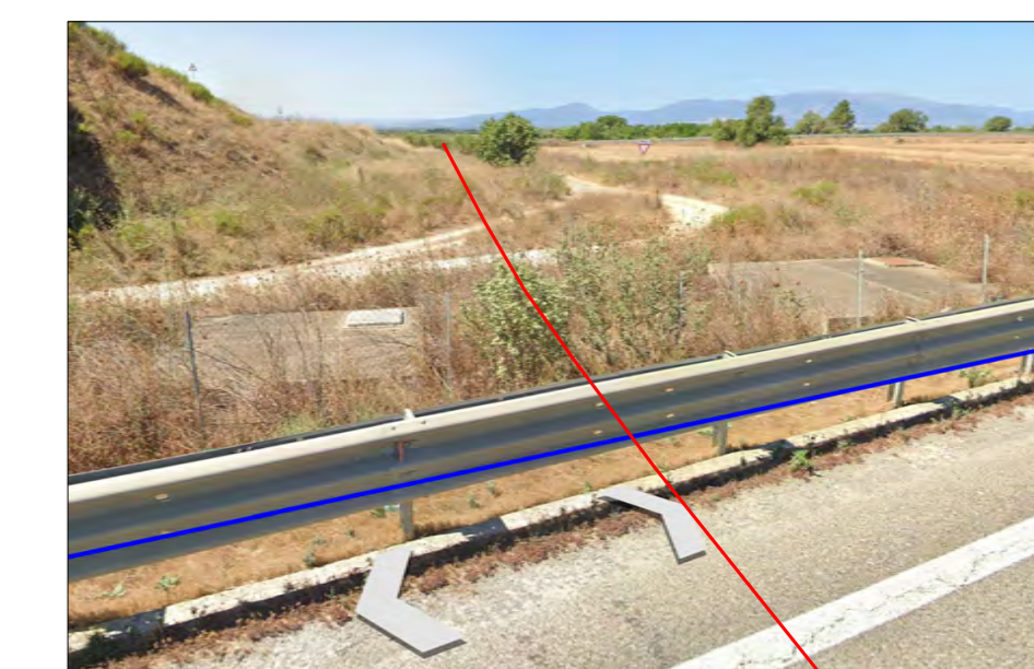
Interferenza idrica n.3 Condotta adduttrice Corongiu-Sa Forada
