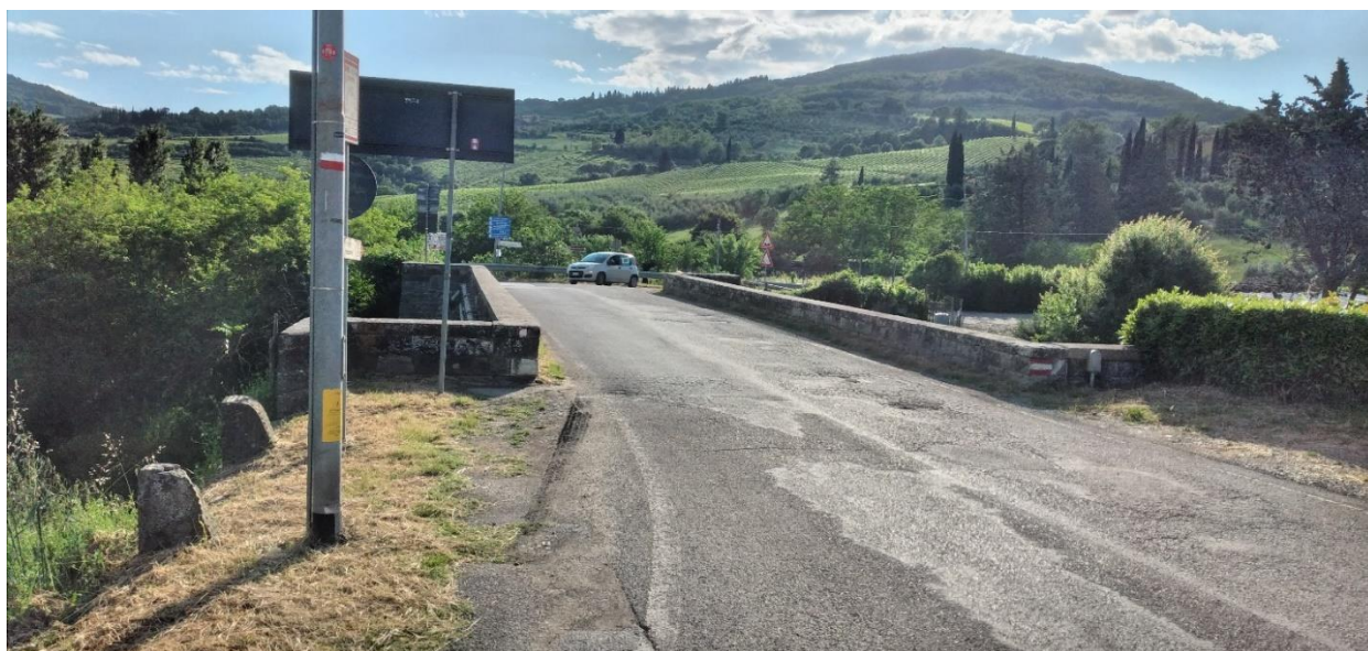
Foto 26 ponte storico - Torrente Argemenna
