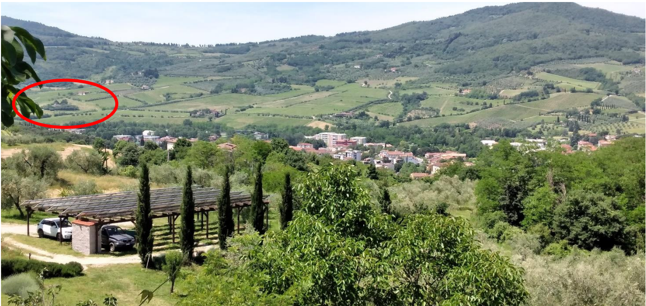
Foto 16 - visuale dalle colline di Rufina del tratto in rilevato su Montebonello (nel cerchio la zona con 7 metri)
