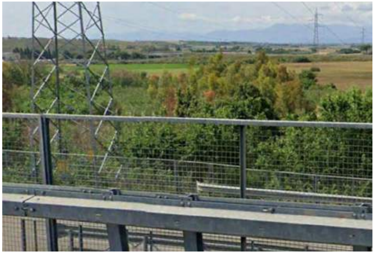
Interferenza 06 con Rio Piras. Risoluzione interferenza tramite tecnica attraversamento di ponte.
