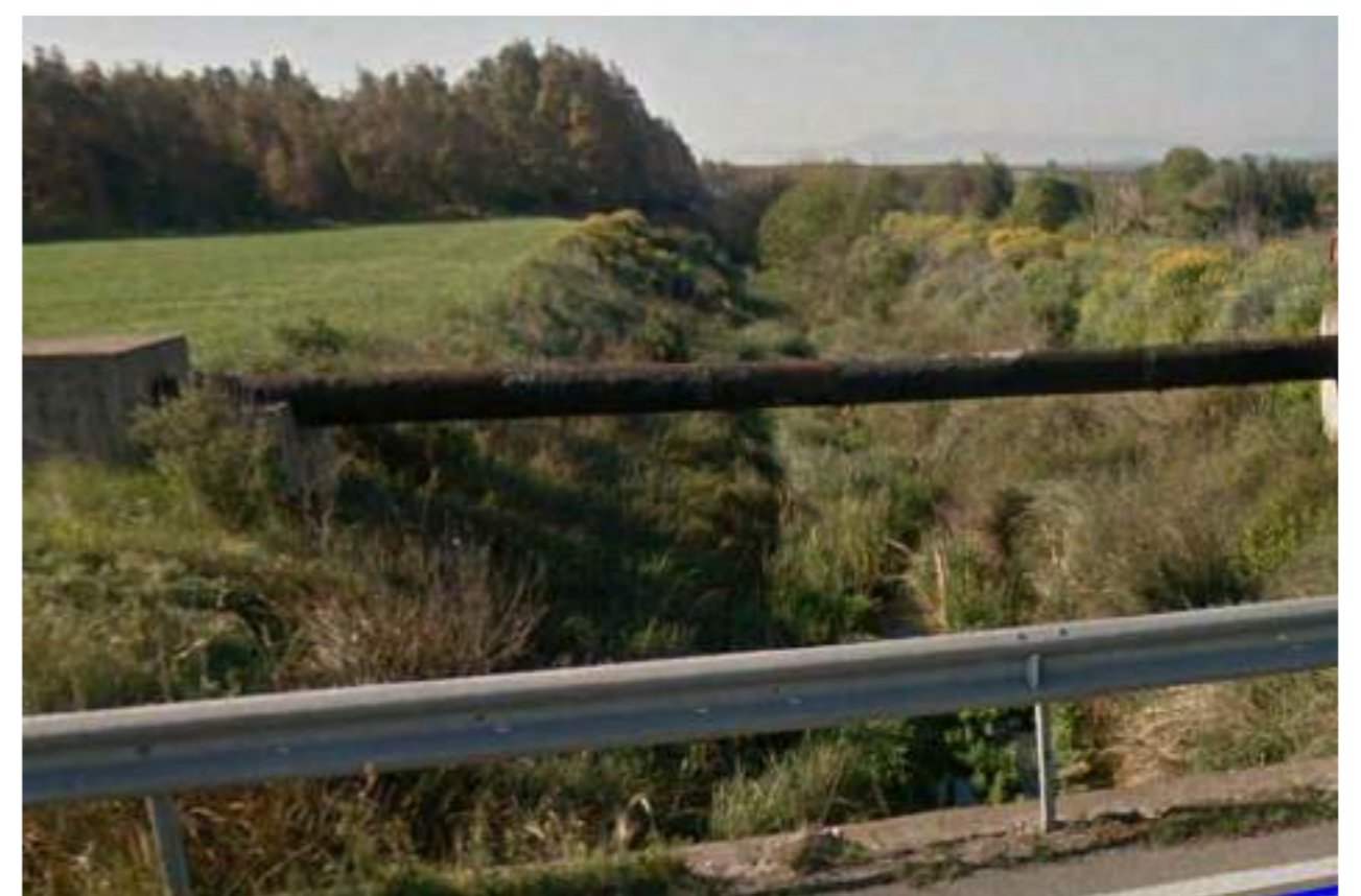
Interferenza 03 con Rio Brunco Fenogu. Risoluzione interferenza tramite tecnica attraversamento di ponte.
