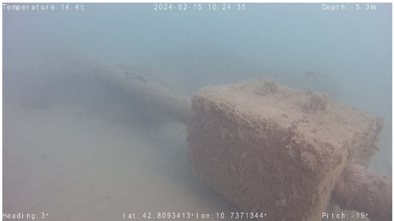
Figura 34- transetto 16: Particolare tubazione con blocco sollevata dal fondo.
