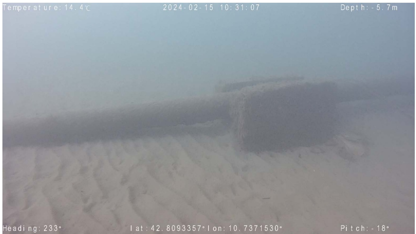
Figura 36- transetto 17: Particolare tubo sollevato con blocco già identificato in Fig. 34.
