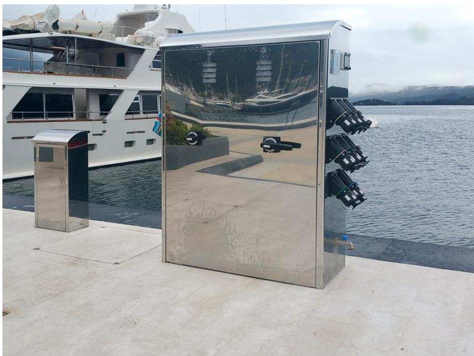
**Fig. 2.1 colonnine per amperaggi oltre 125 A (fino a 400÷500A)**
