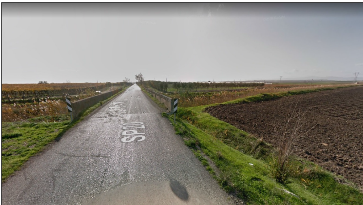
Figura 8. Ponte sulla SP20 che incrocia il canale Santa Maria.
