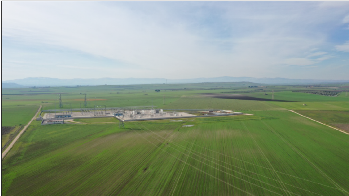
Figura 3 – Vista aerea della stazione elettrica Terna “San Severo”.
