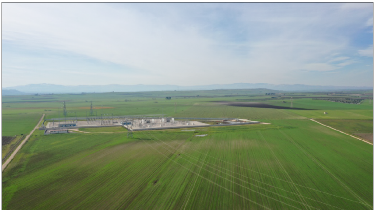
Figura 6 - Vista aerea della Stazione Elettrica Terna "San Severo"..
