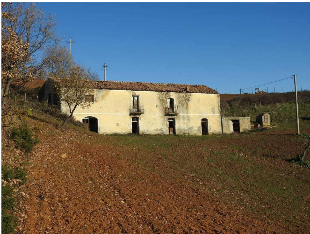
FIG. 4.2.1.1: Esempio di rifugio potenziale nell'area di studio
