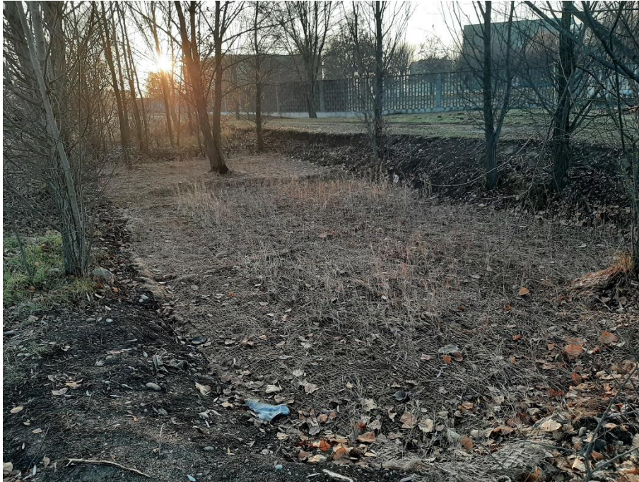
Figura 13: area umida a conclusione dell'intervento, con la stesa dei tappeti vegetati. Il pelo libero dell'acqua potrà variare a seconda della stagionalità, ottimizzando i processi fitodepurativi e i benefici ecologici rispetto a un laghetto sempre colmo.
