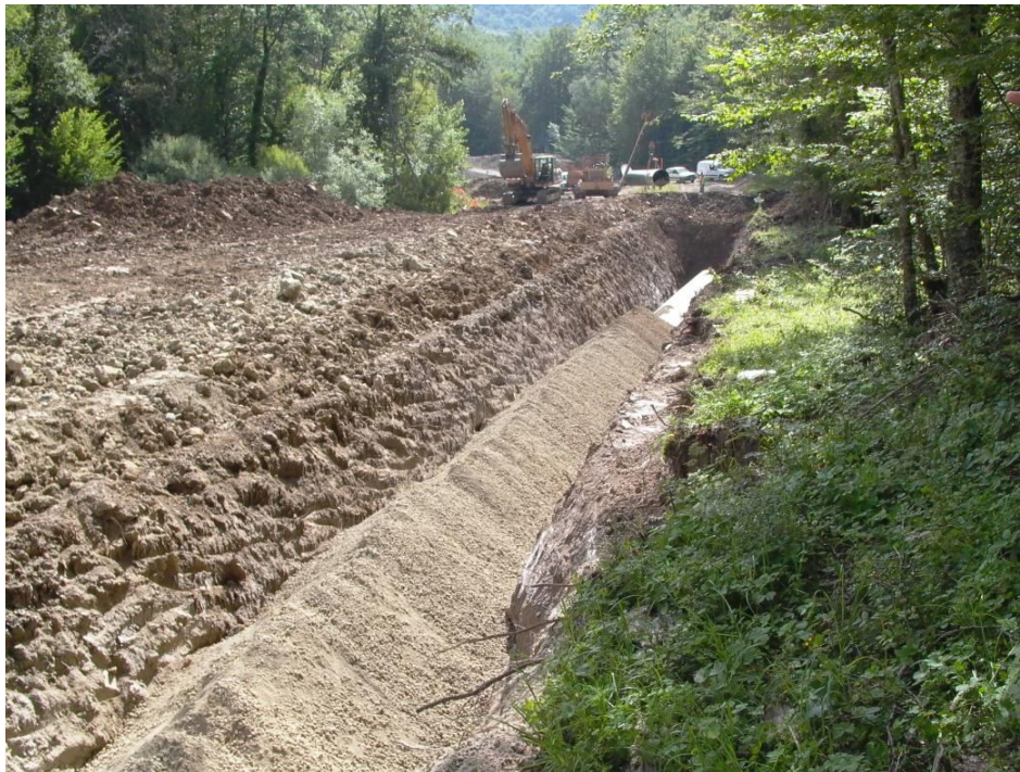
Figura 8-4: Rinterro della condotta
