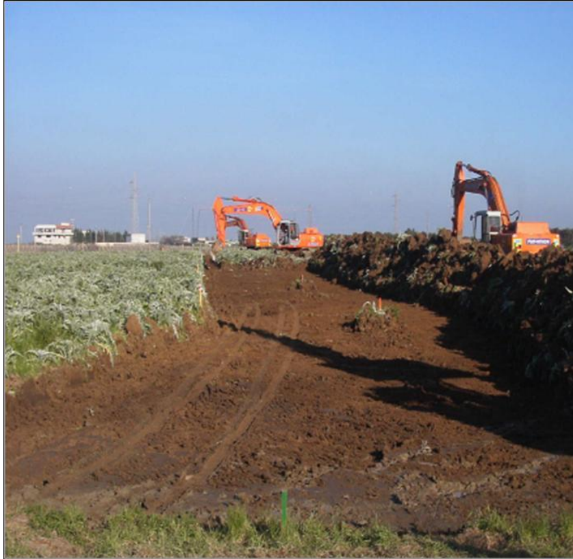
Figura 8-1: Foto apertura dell'area di passaggio
