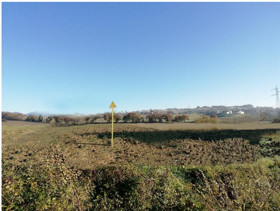
Figura 3-3: Pista lavori a ripristini ultimati
