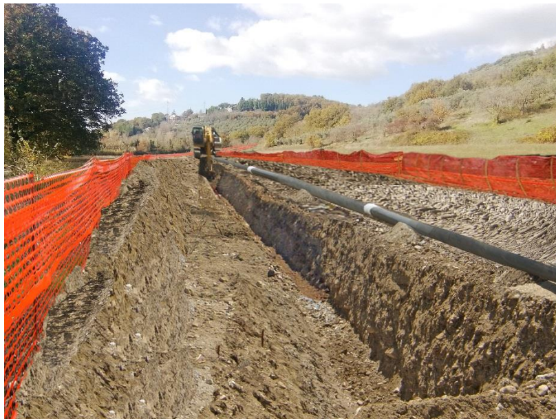
Figura 8-3: Scavo della trincea
