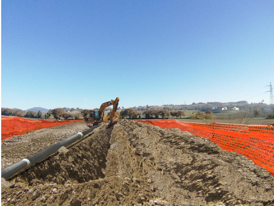
Figura 3-2: Fase di cantiere
