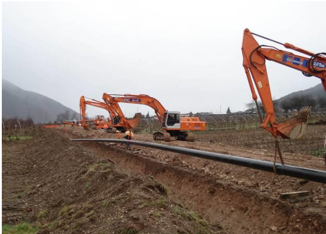
Figura 2.7/A – Posa della condotta
