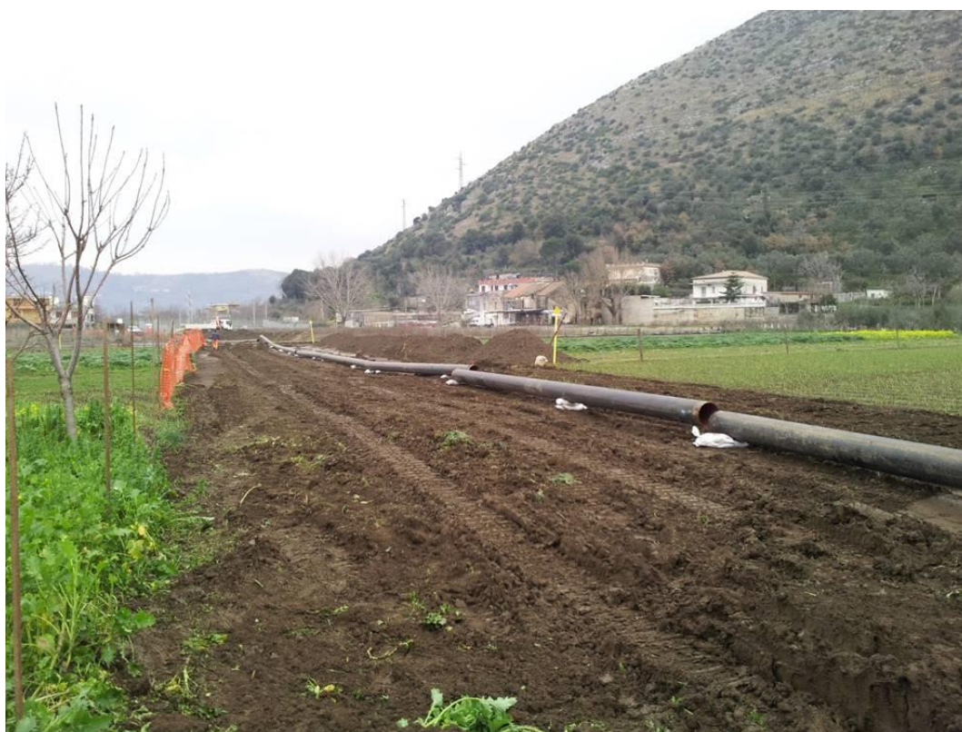
Figura 2.3/A – Sfilamento tubazioni
