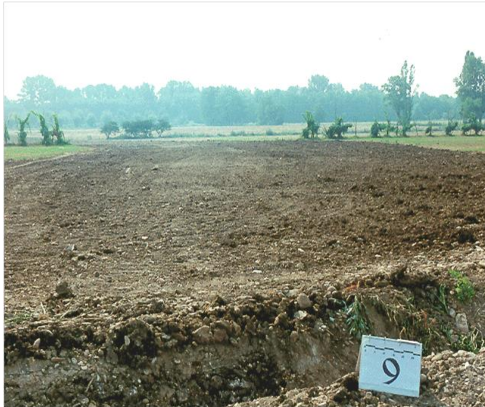
Figura 2.7/B – Rinterro della condotta
