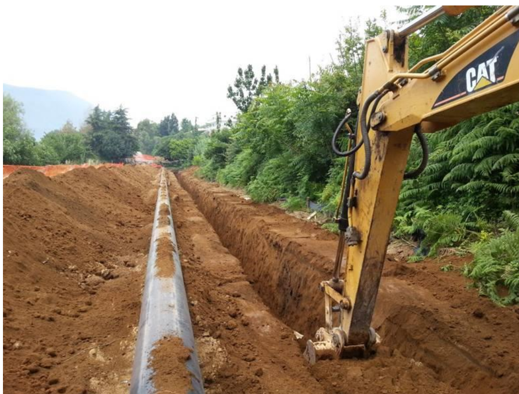
Figura 2.5/A – Scavo della trincea
