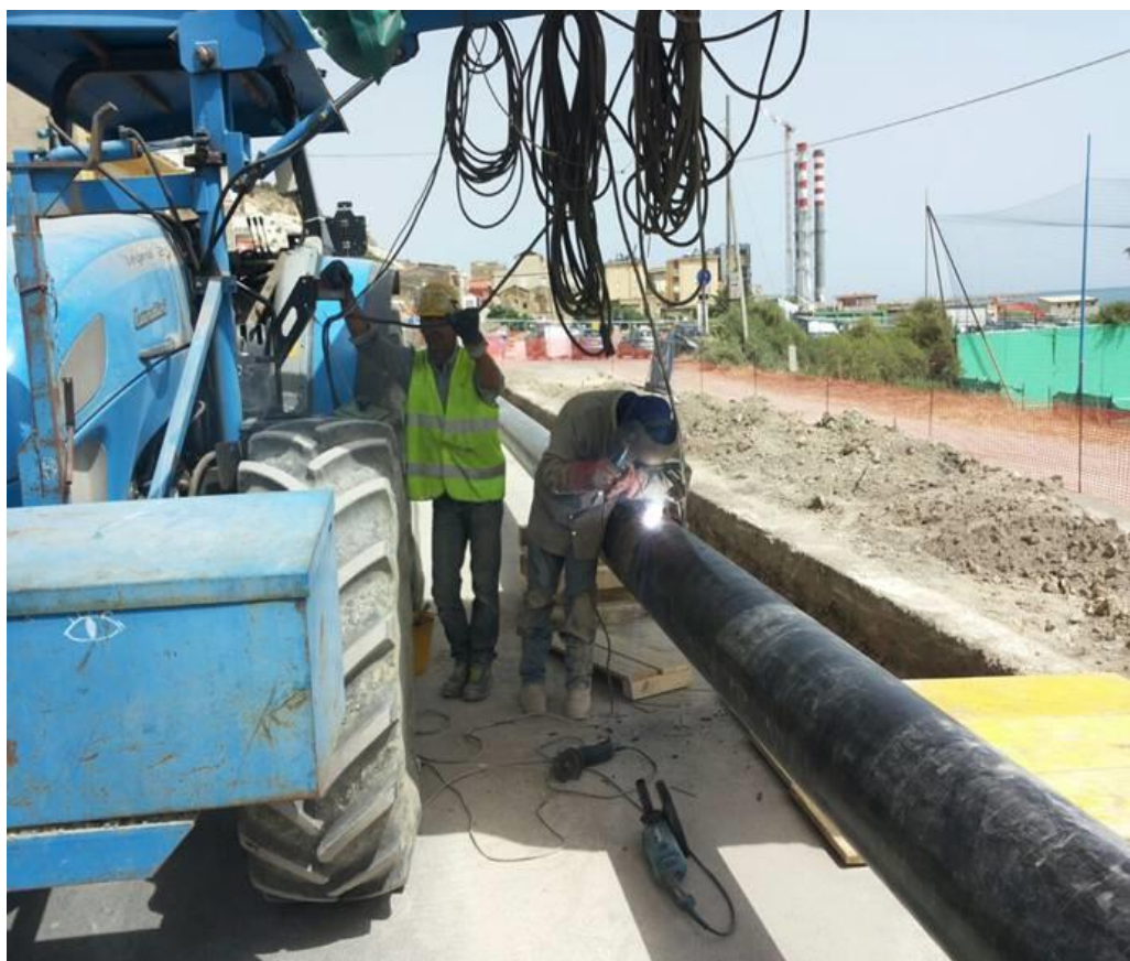
Figura 2.4/A – Foto tipica della fase di saldatura
