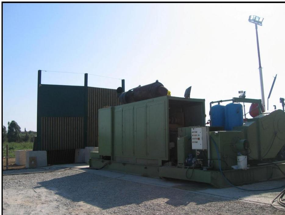
**Figura 3.4.4c** *Generatori Elettrici ad Alta Insonorizzazione*
