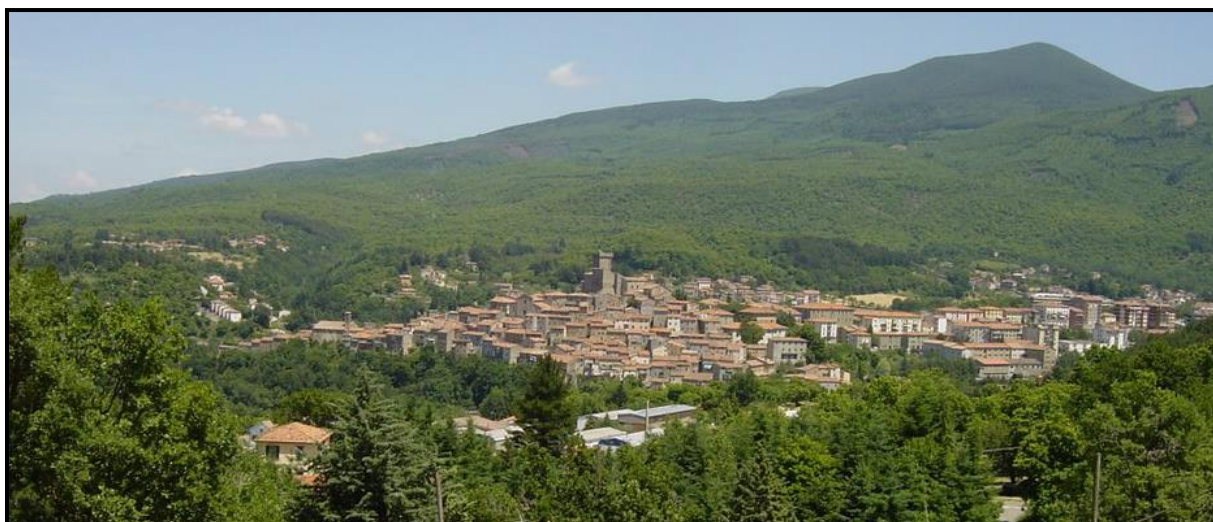
Figura 4.2.8b Vista di Arcidosso
