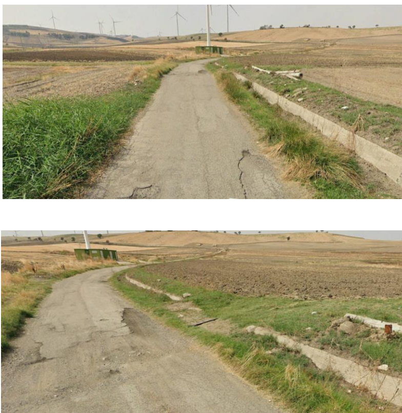
Figura 14 – Foto dello stato dei luoghi nei pressi dell’interferenza denominata I13 si mostra la totale assenza di linea d’impluvio e nessuna presenza di opere idrauliche
