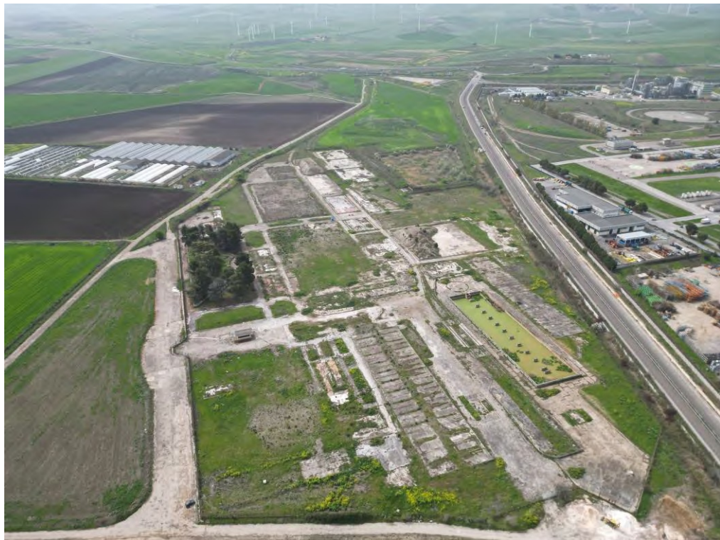
Figura 1. Inquadratura tramite drone di parte dell' "Area NORD"
