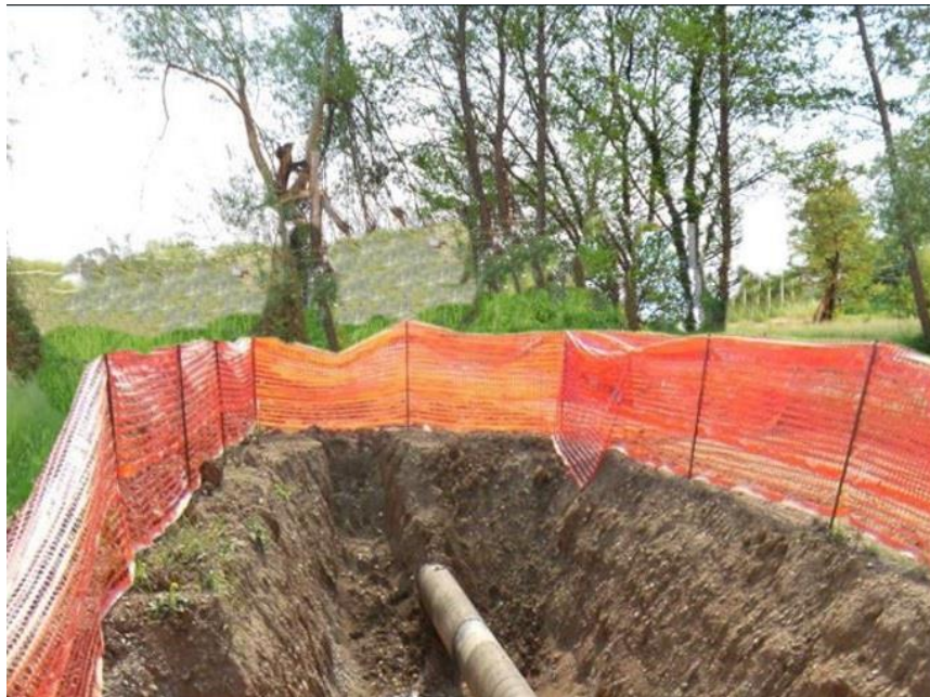
Figura 3-5: Esempio Dismissione Impianto - cantiere in corso
