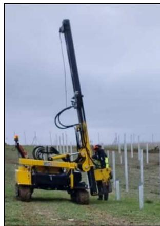
*Macchina per pali – Potenza acustica: 85 dBA (testa battente in gomma semirigida)*
