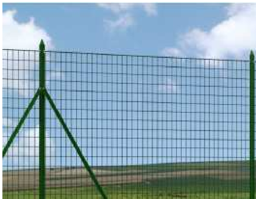
Dettaglio della recinzione perimetrale
