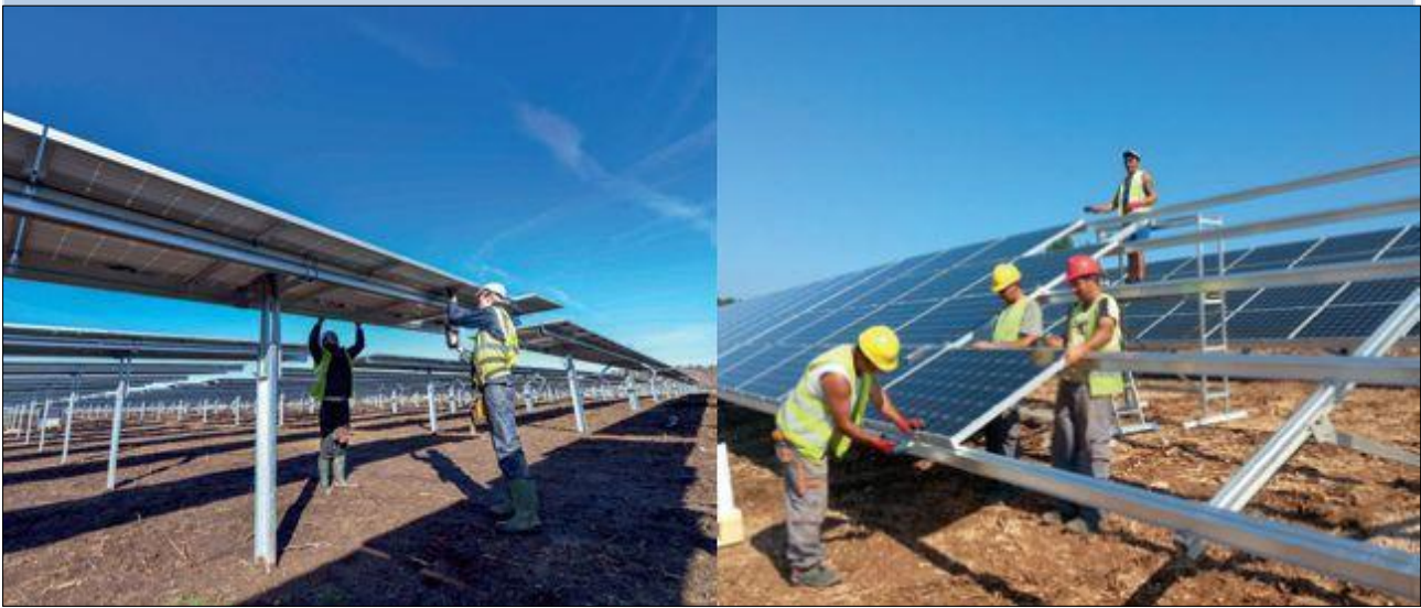
Figura 18: Montaggio tracker e moduli fotovoltaici
