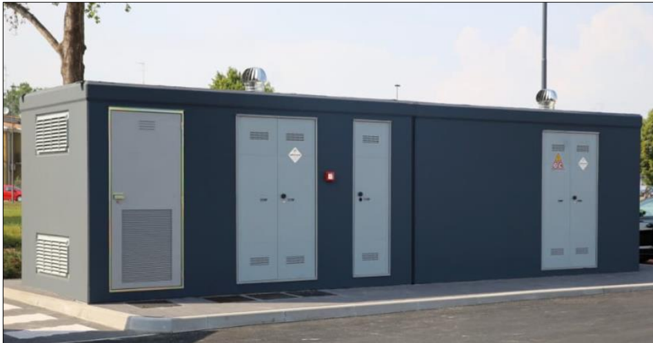
Figura 3: Tipica cabina di smistamento
