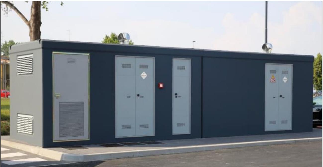
**Figura 4: Tipica cabina di smistamento**
