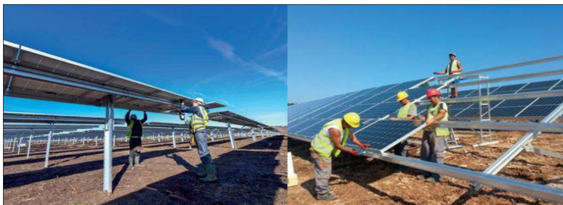
Figura: Montaggio tracker e moduli fotovoltaici
