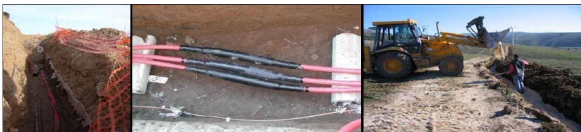
Figura: Scavo con posa cavi
