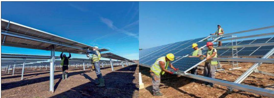
**Figura: Montaggio tracker e moduli fotovoltaici**
