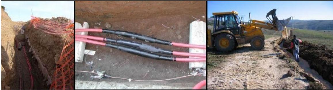
**Figura: Scavo con posa cavi**
