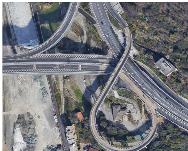
Figura 4. Stato dei luoghi ad oggi
