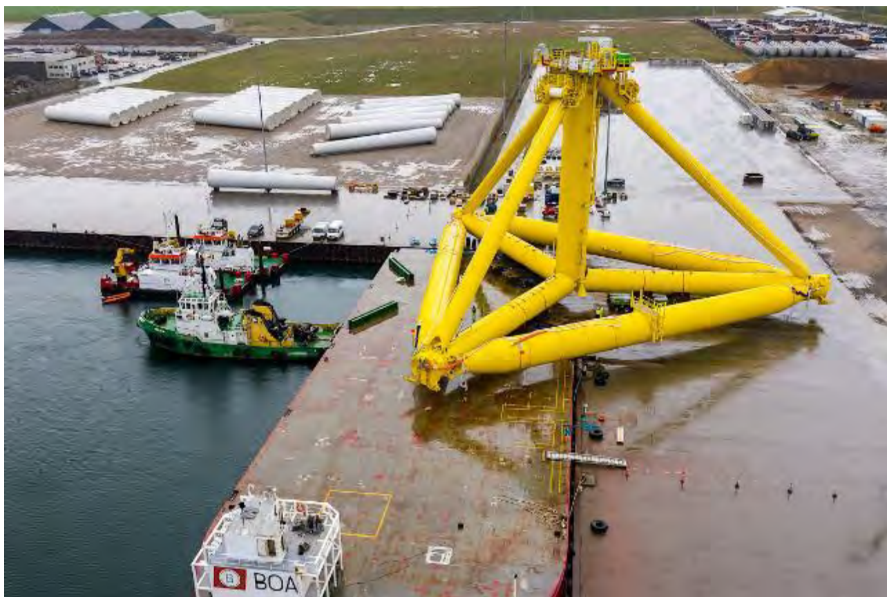
Figura 34 – Una fondazione galleggiante Tetraspar con applicazione del coating protettivo.
