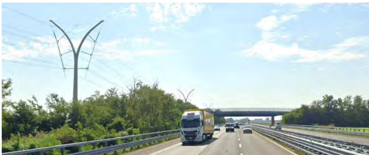
Figura 205 – Tralicci monostelo e germoglio lungo la autostrada A7.
