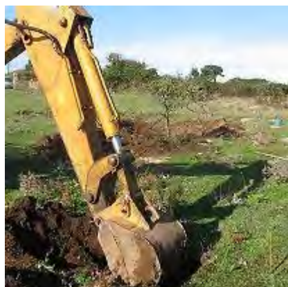
Preparazione delle aree di impianto
