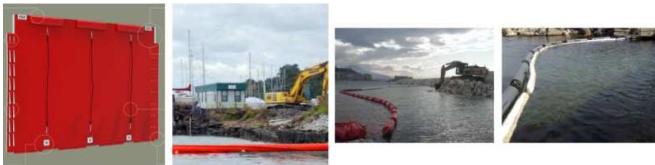
Figura 7.75 – Dispositivi anti-intorbidimento per il confinamento delle aree di lavoro a mare.
