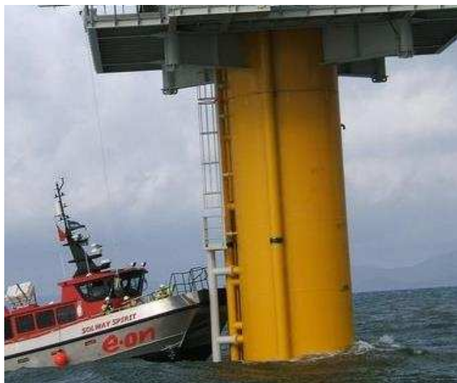
Soluzione di approdo da nave con sistema “boat landing” tipico dei sistemi a fondazione fissa
