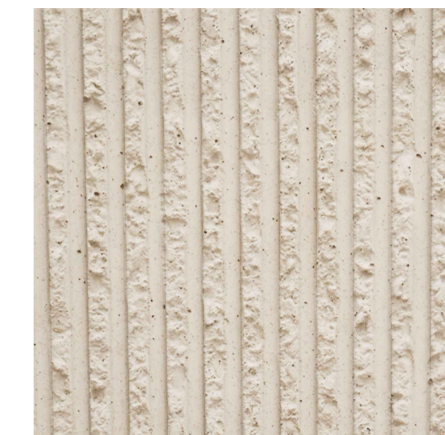
Particolare recinzione esterna
