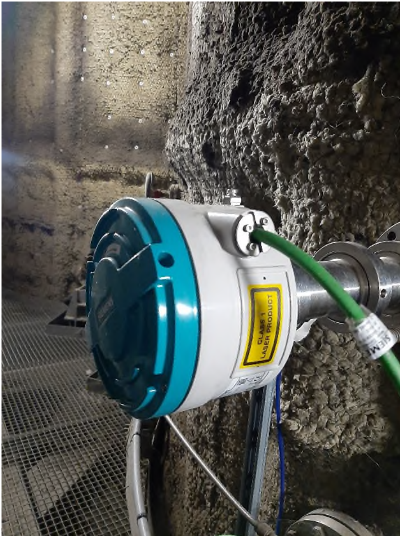
Figura 4 - Ricevitore dell'analizzatore al camino E2
