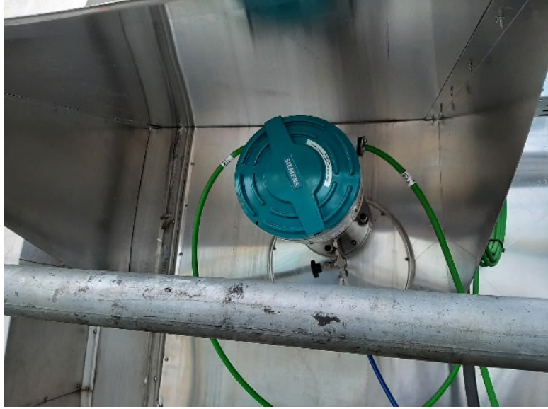
Figura 1 - Emittitore dell'analizzatore al camino E1
