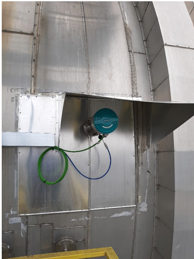
Figura 2 - Ricevitore dell'analizzatore al camino E1
