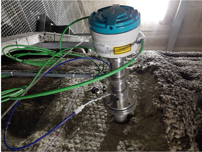
Figura 3 - Emittitore dell'analizzatore al camino E2
