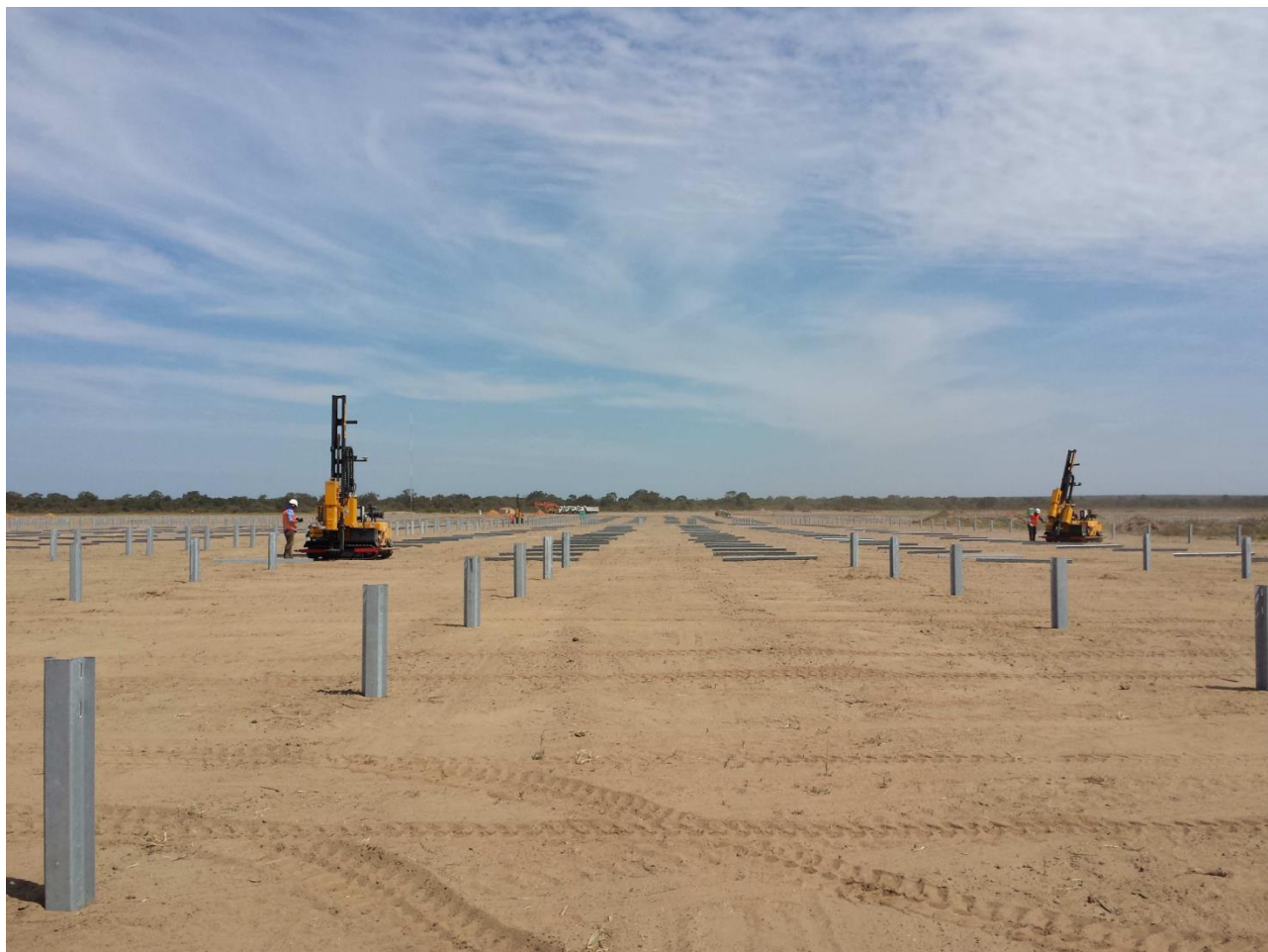
Figura 7.3 – Fase di infissione dei pali con profilo omega
