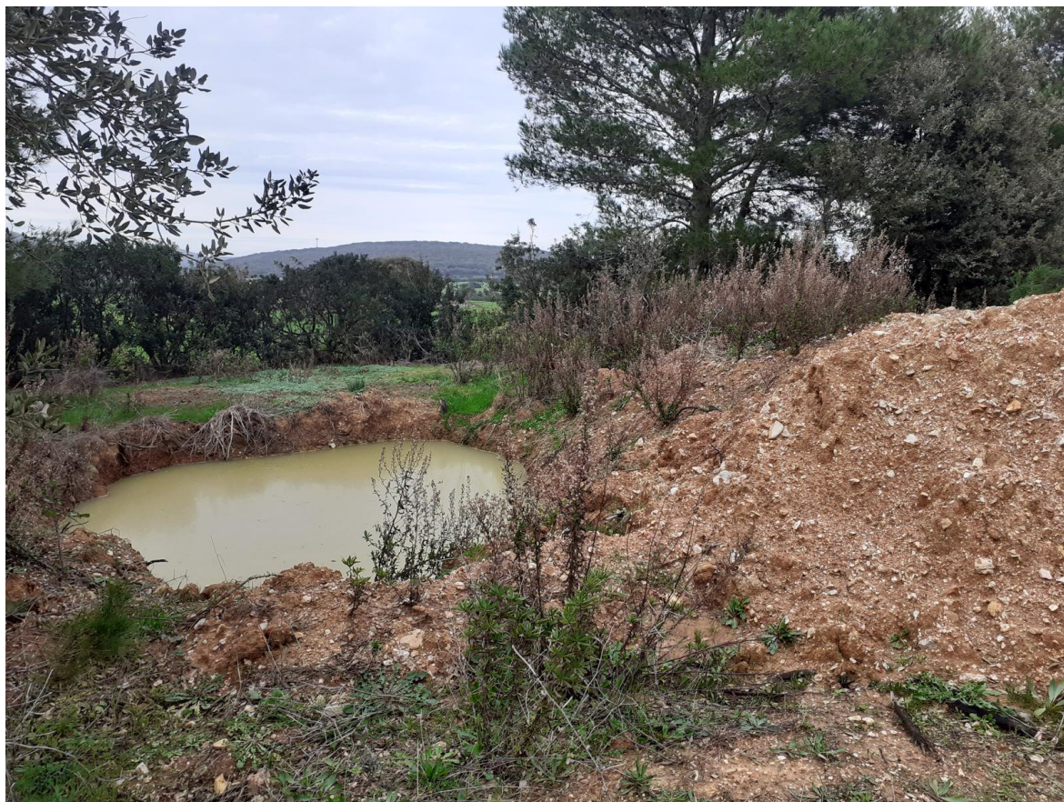
Figura 3.3 - Area del campo FV: lughetto artificiale e materiale di risulta dallo scavo in coord. 1440251.973,4507189.571 (punto 2)
