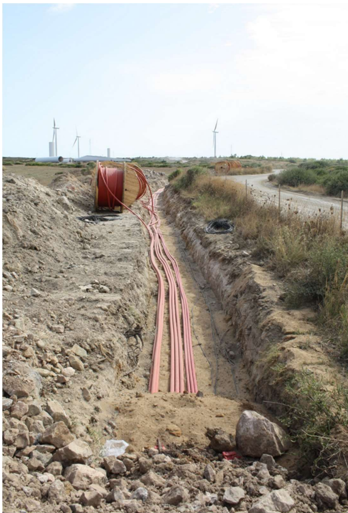
Figura 3.4 - Tipico scavo e linee interrato
