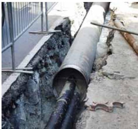
*Figura 3.12 – Cavo interrato 132 kV dotato di schermatura mediante tubo ad alta permeabilità magnetica.*
