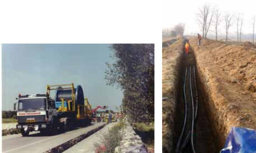
*Figura 3.4 - Esempi di posa cavi in sede stradale (Italia): cavo 400 kV cc (sx); cavo a singola terna 380 kV (dx).*
