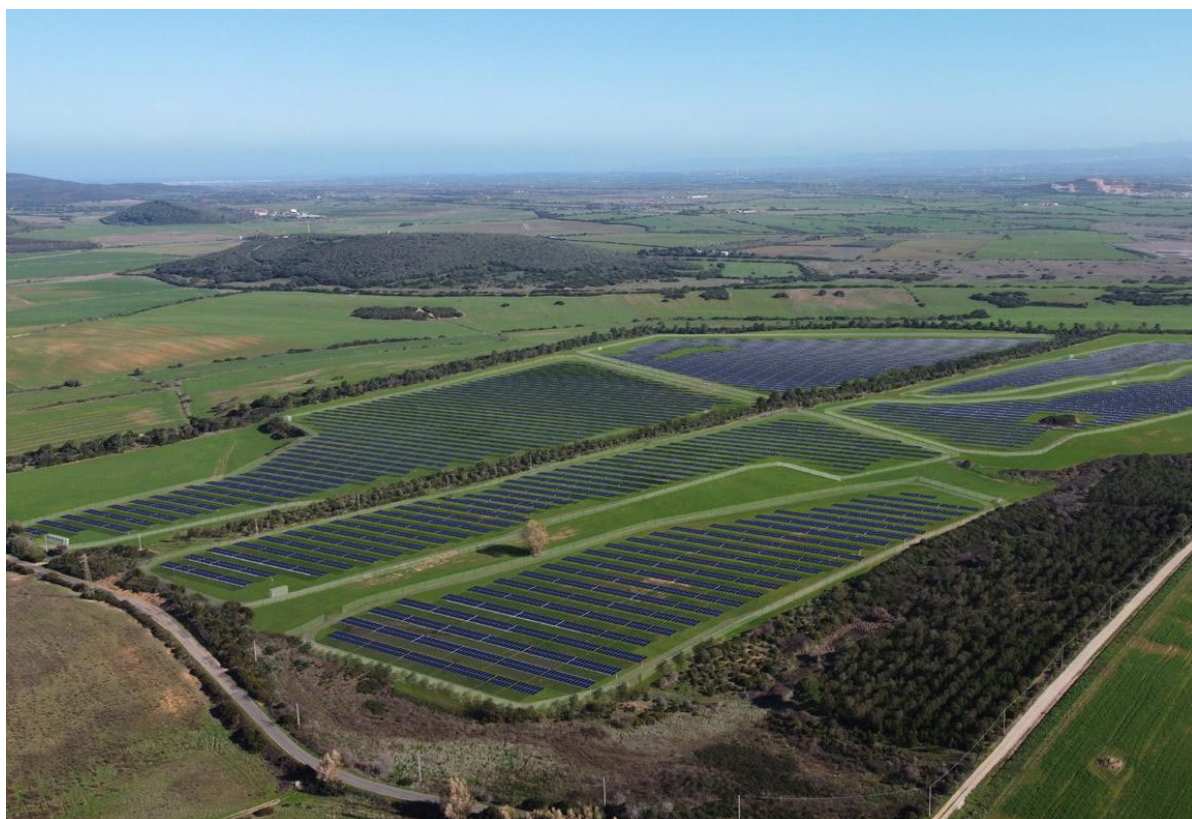
Figura 10.1 - Fotosimulazione della ripresa aerea da drone realizzata da sud-ovest verso nord-est
