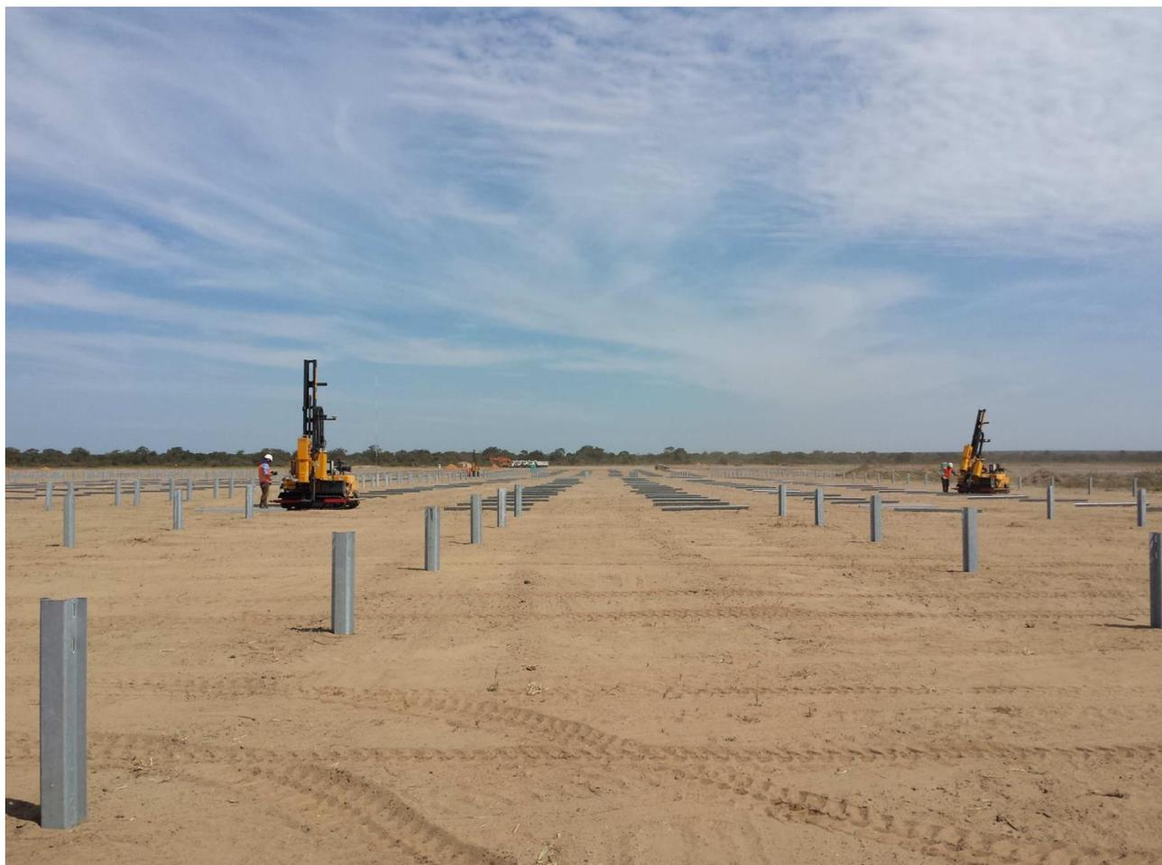
*Figura 5.8 – Fase di infissione dei pali con profilo omega*
