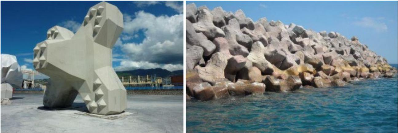
**Fig.4: Mantellata single-layer in massi artificiali tipo Ecopode<sup>TM</sup> (dx, parti emerse) e tipo Accropode<sup>TM</sup> (sx, parti sommerse)**
