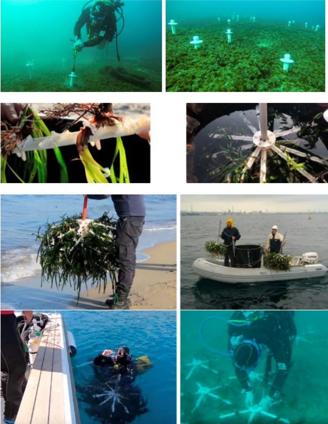
**Fig.16: Fasi di processo trapianto di Posidonia**
