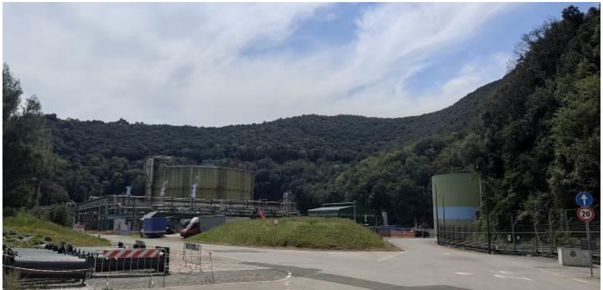
Figura 95 - Vista area interventi allo stato attuale
