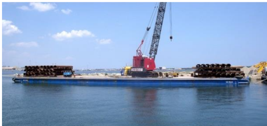
Figura 11 - Pontone secondario per stoccaggio pali
