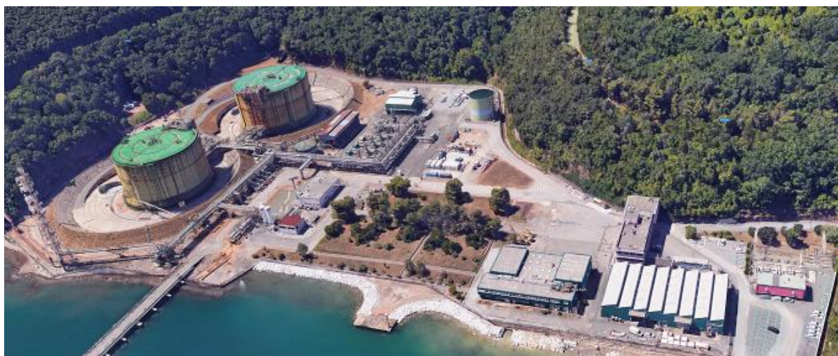
Figura 93 - Vista del Terminale dall'alto allo stato attuale
