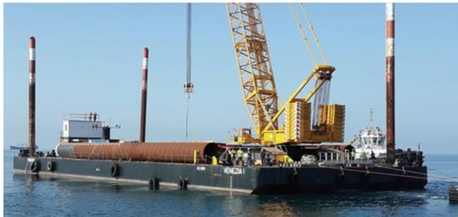
Figura 10 - Pontone principale con gru per sollevamento e infissione pali
