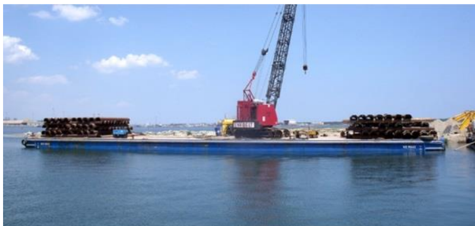
Figura 53 - Pontone secondario per stoccaggio pali
