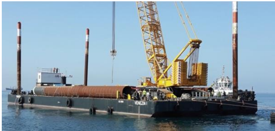
Figura 52 - Pontone principale con gru per sollevamento e infissione pali
