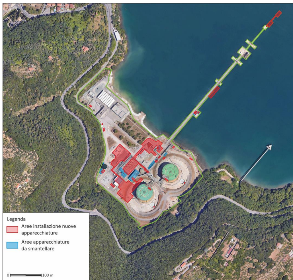
Figura 7 - Ubicazione delle aree di intervento
