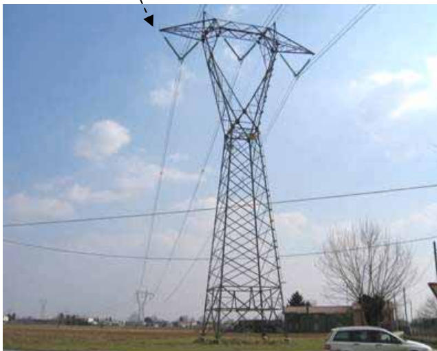
Figura 2.2 – Tipico sostegno a traliccio – singola terna (sinistra) esempio di sostegno tubolare monostelo – linea compatta (destra).
