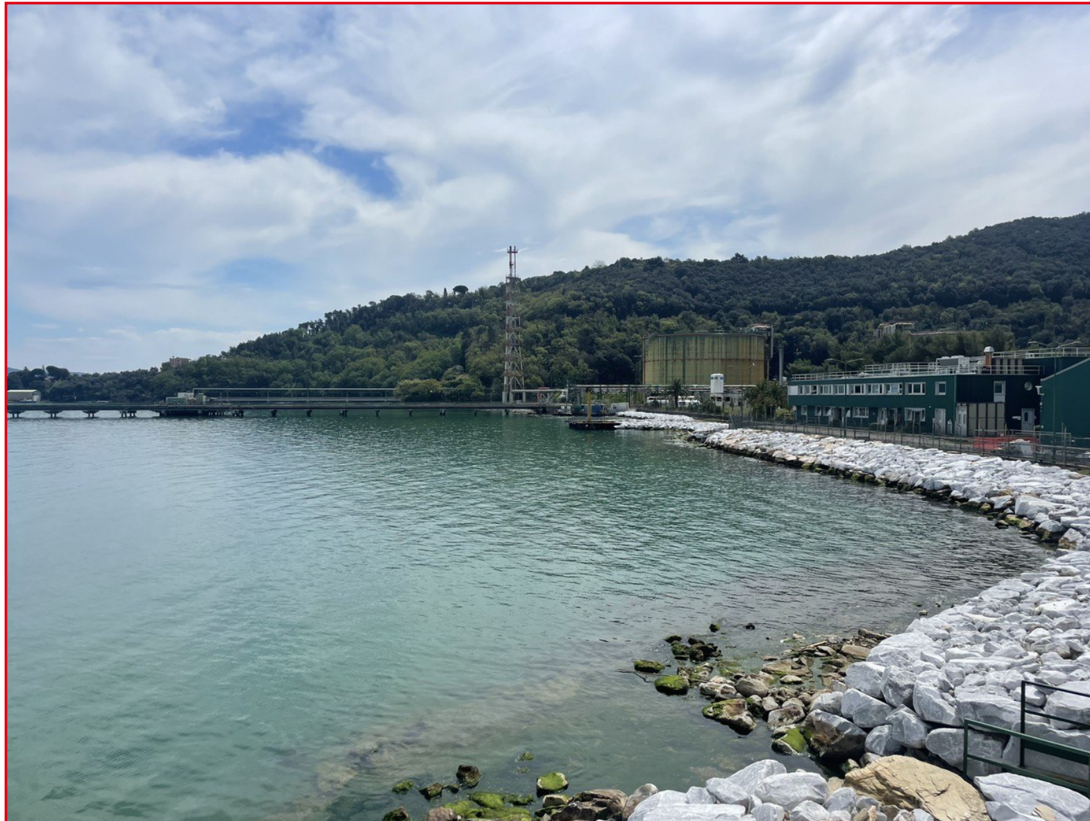
Fig. 3. Contesto ambientale dell'impianto GNL ripreso da nord
