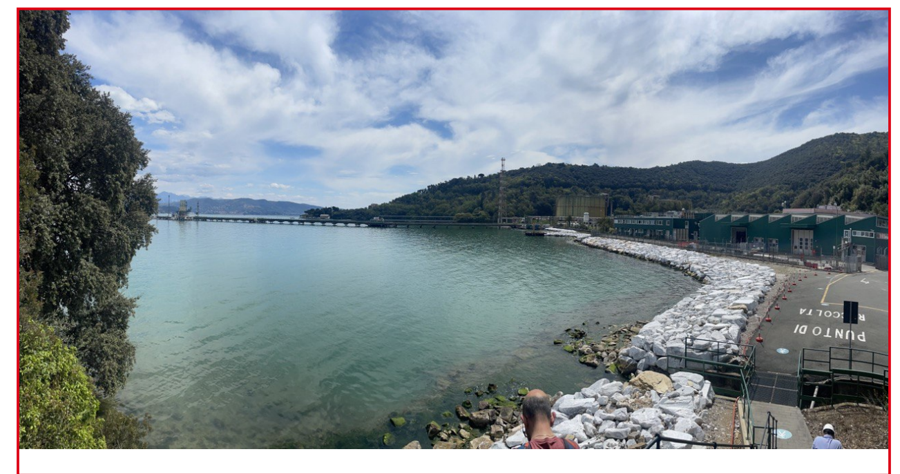
Fig. 2 - Vista dell'impianto interessato dal progetto
