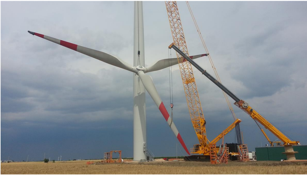
Figura 2. Smontaggio delle pale
