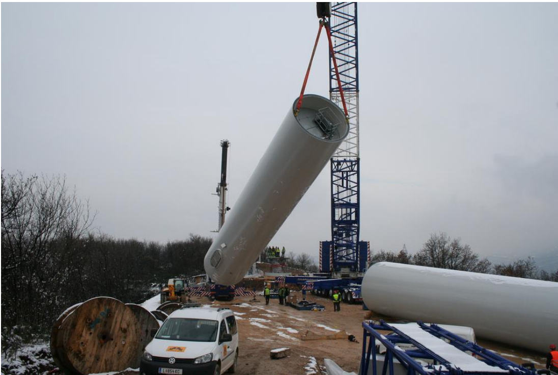
Figura 3. Smontaggio dei tronchi
