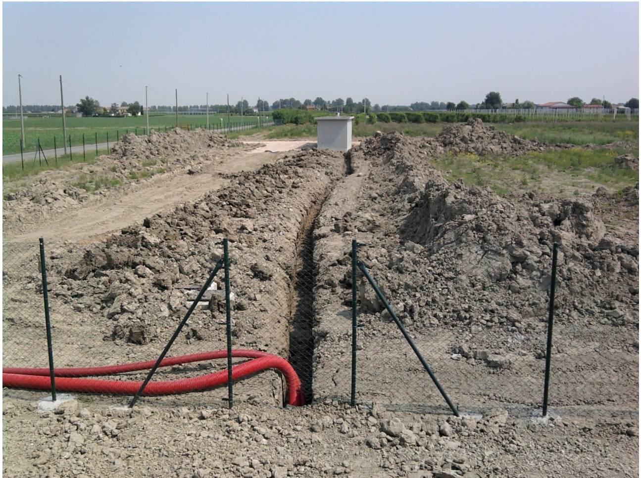
Figura 6 | Tipico di realizzazione di cavidotto interrato
