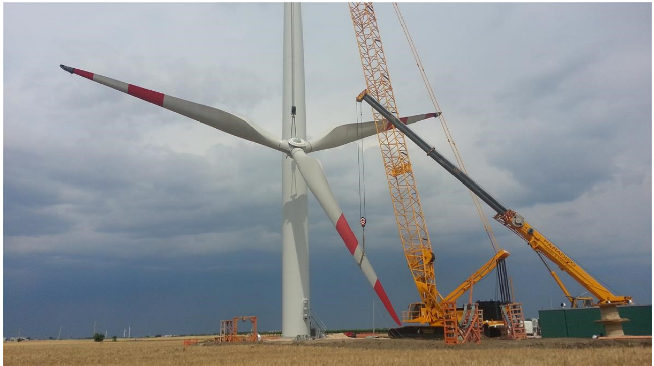
Figura 5 | Operazioni di montaggio aerogeneratori
