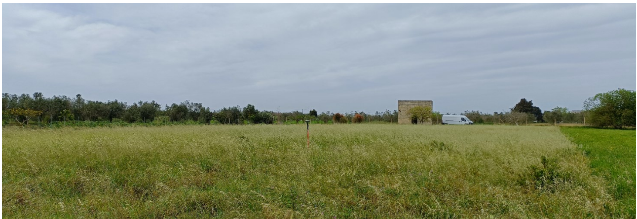
Figura 28 | Stato attuale - WTG08
