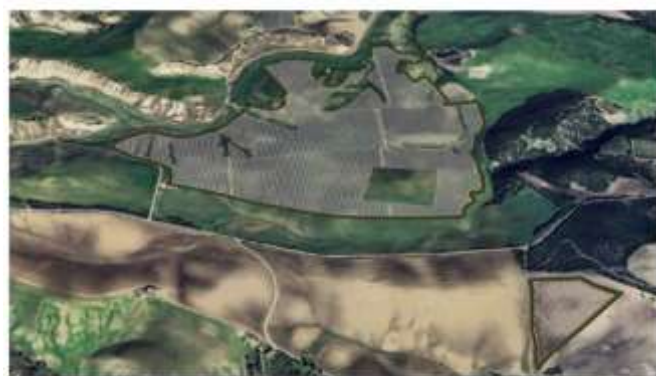
VISTA NORD - IMPIANTO PIANO MELE
