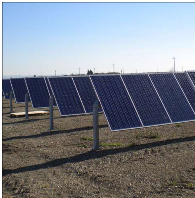
Figura 12 – Rappresentazione della struttura di supporto vista frontale
