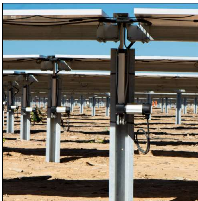
Figura 13 – Rappresentazione della struttura di supporto vista posteriore
