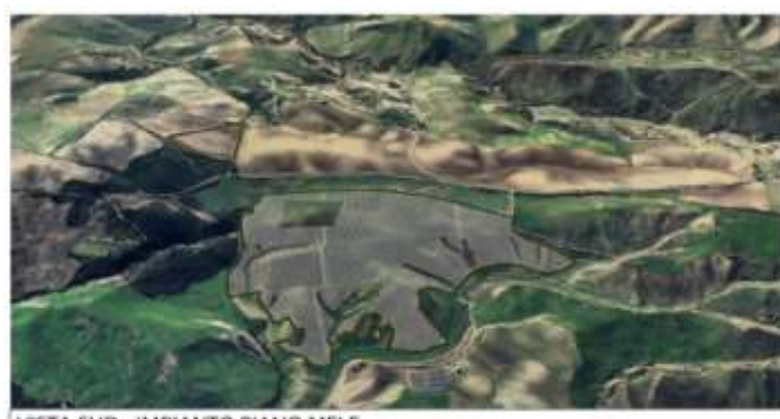
VISTA SUD - IMPIANTO PIANO MELE
