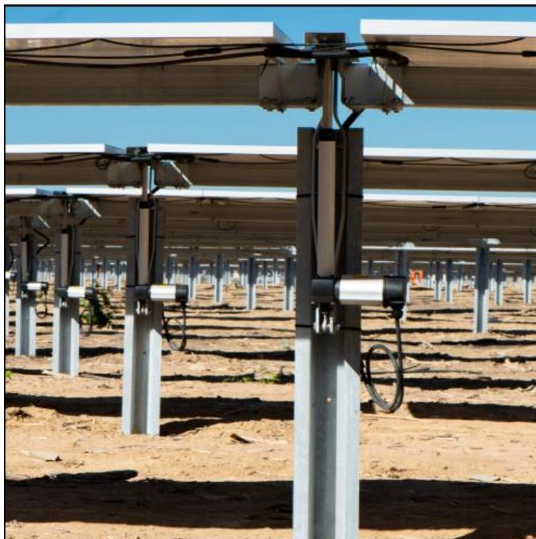
**Figura 6** – Rappresentazione della struttura di supporto vista posteriore
