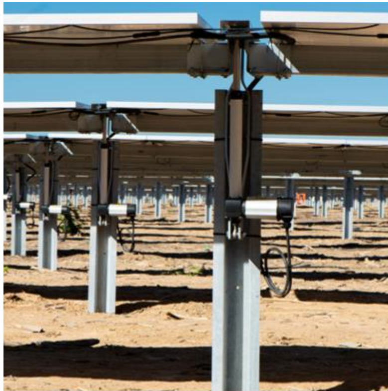
Figura 6 - Rappresentazione della struttura di supporto vista posteriore
