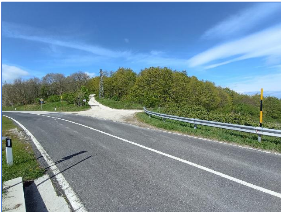
Fig. 3 – Pescopagano (PZ), loc. Granito, cavidotto WTG3/4-WTG8: particolare del distacco dalla SS7 Appia.
