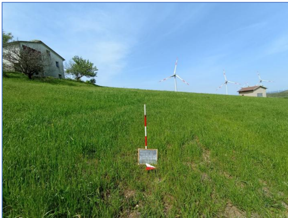
Fig. 1 – Pescopagano (PZ), loc. Coste dell'Abetino, cavidotto esterno, panoramica, da E.
