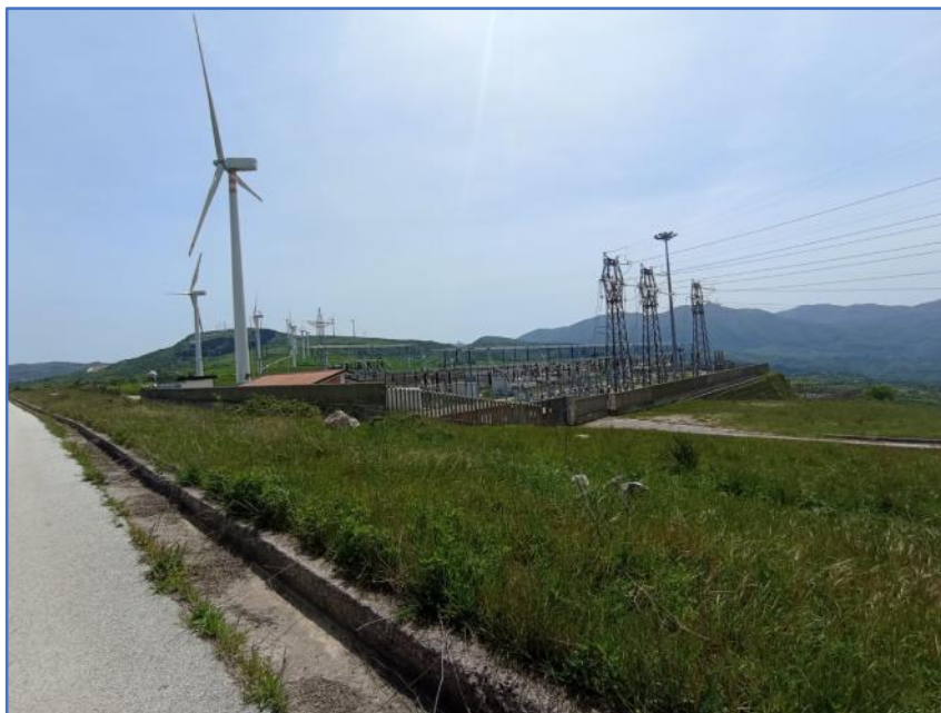
Fig. 2 – Castelnuovo di Conza (SA), loc. Seta, Sottostazione Elettrica, panoramica, da O.
