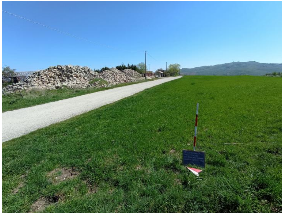
Fig. 3 – Pescopagano (PZ), loc. Piano dell’Albero, cavidotto WTG1/WTG2-WTG3: panoramica, da O.
