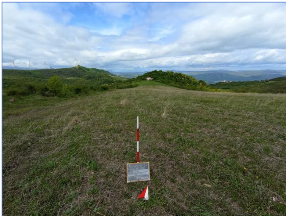
Fig. 1 – Pescopagano (PZ), loc. Mass. Tullio, cavidotto WTG9-WTG10: panoramica, da S.
