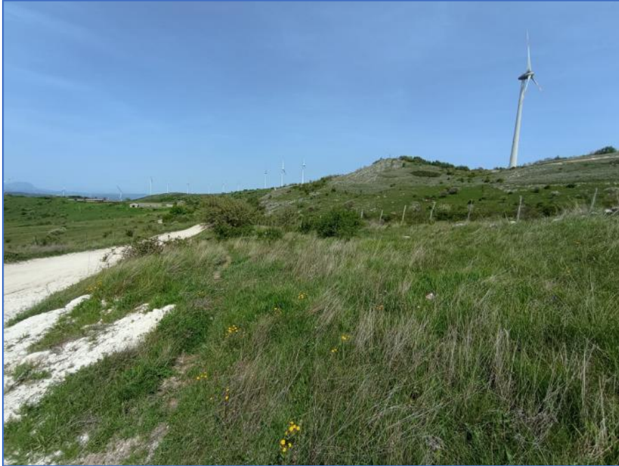
Fig. 3 – Santomenna (SA), loc. M.te Petrella, cavidotto esterno, panoramica, da E.
