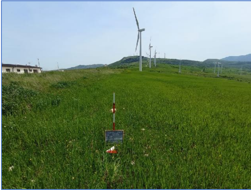
Fig. 5 – Conza della Campania (AV), loc. Seta, cavidotto esterno, panoramica. da O.
