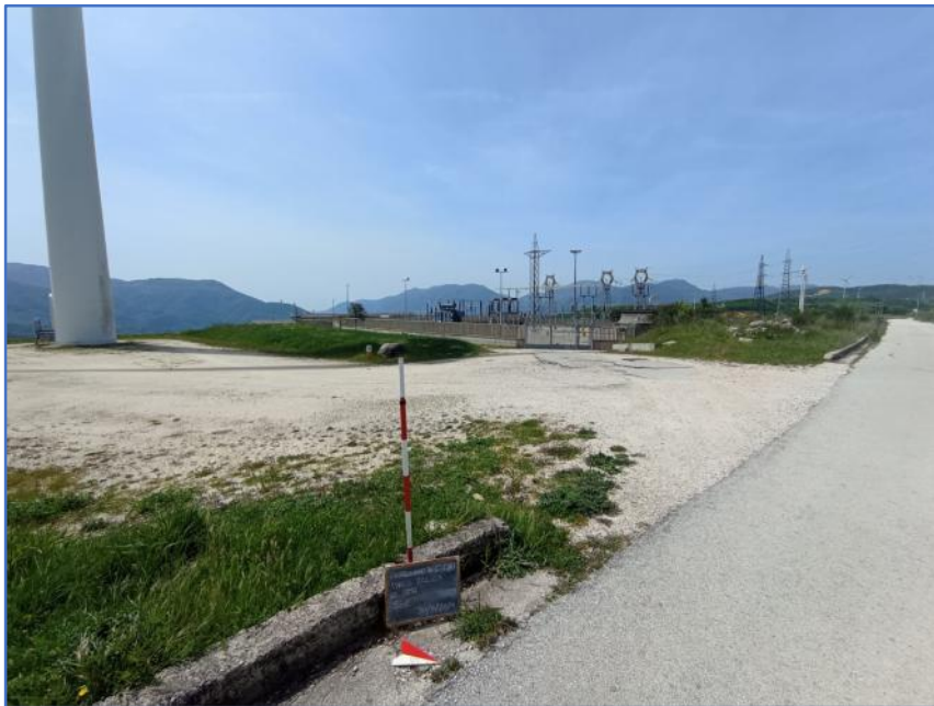
Fig. 1 – Castelnuovo di Conza (SA), loc. Seta, Sottostazione Elettrica, panoramica, da NE.
