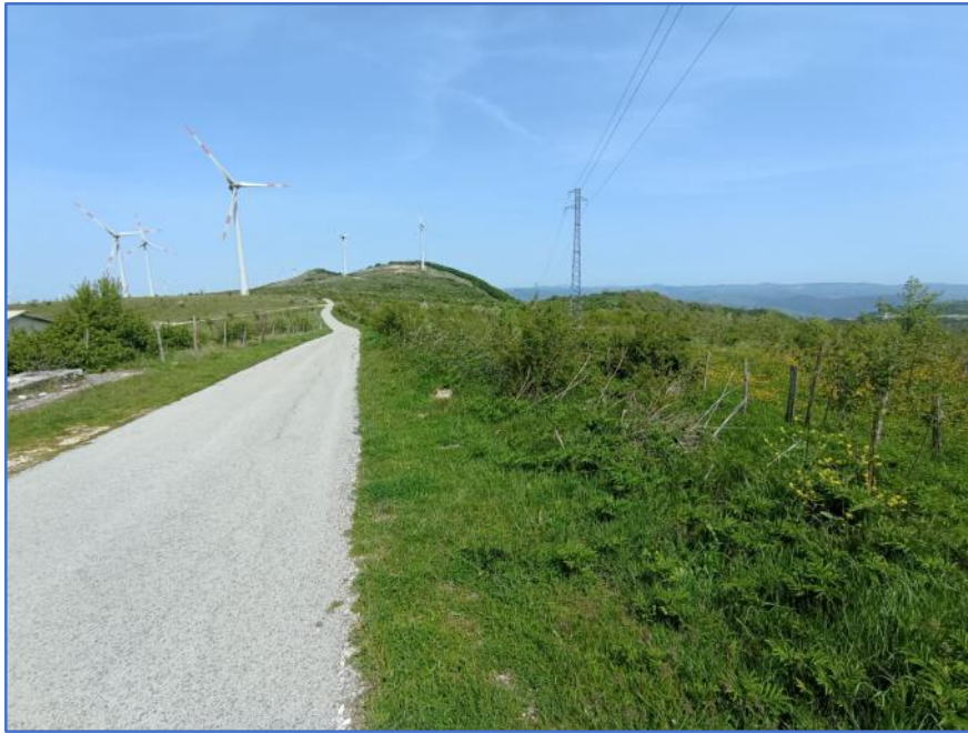
Fig. 3 – Pescopagano (PZ), loc. Coste dell'Abetino, cavidotto esterno, panoramica, da E.
