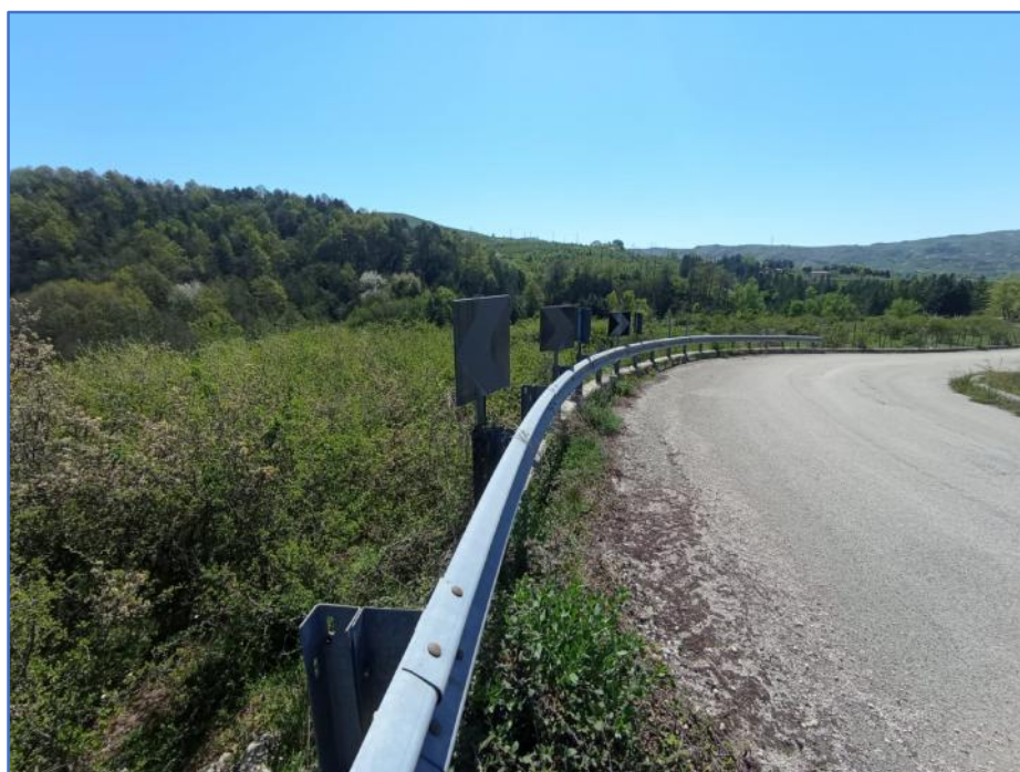
Fig. 2 – Pescopagano (PZ), Mass. Orlando, cavidotto WTG1-WTG2: particolare del settore a monte dell'invaso, caratterizzato dalla presenza di una folta macchia boschiva.
