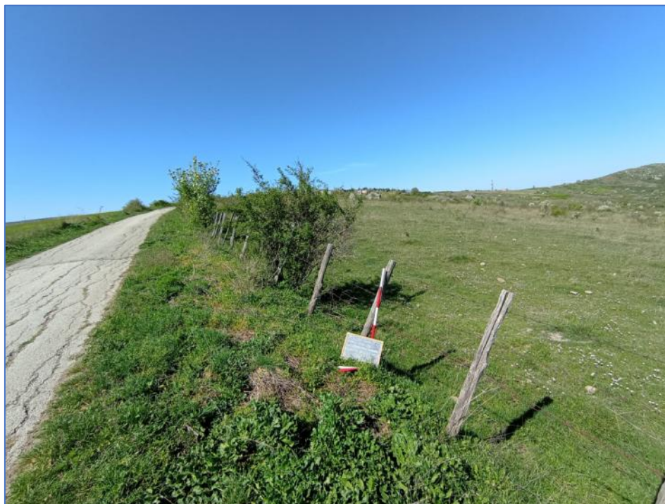
Fig. 1 – Pescopagano (PZ), loc. Piano dell’Albero, cavidotto WTG1/WTG2-WTG3: particolare delle recinzioni sul bordo destro della stradina interpodereale.
