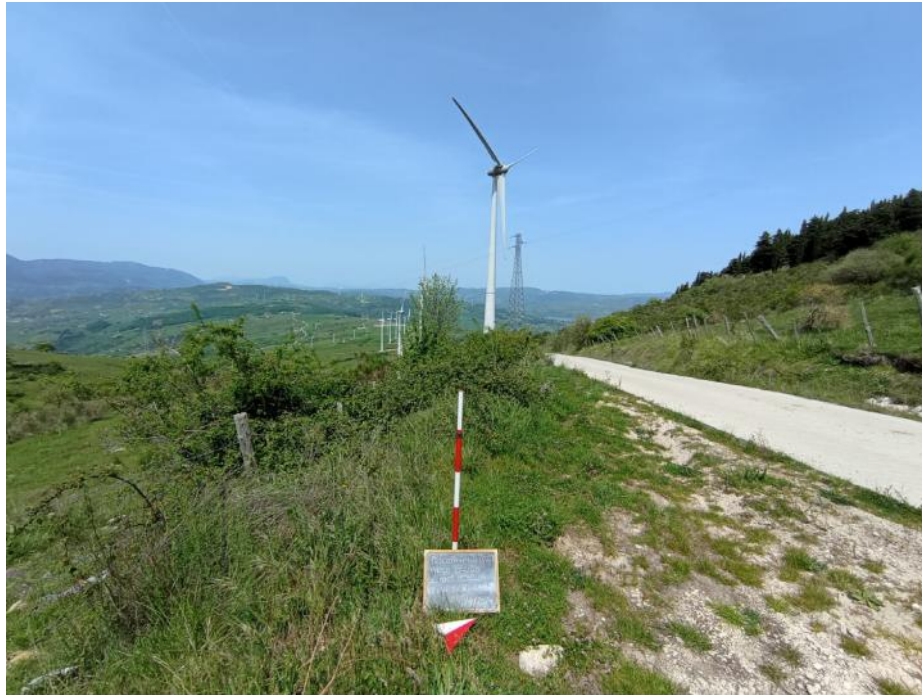
Fig. 5 – Santomena (SA), loc. Cresta della Cesina, cavidotto esterno, panoramica, da E.
