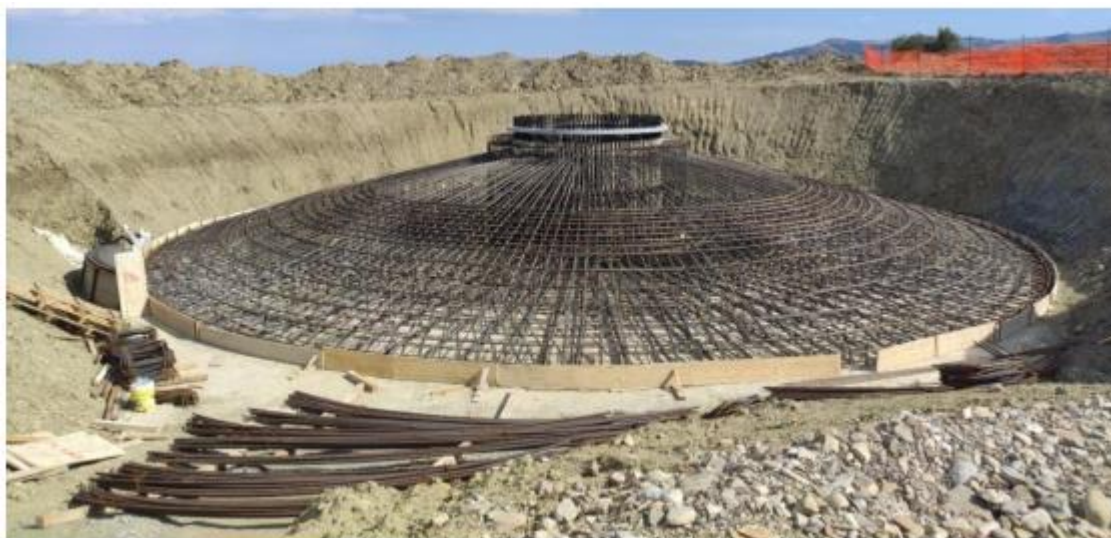
Figura 8 - Armatura plinto tipo
