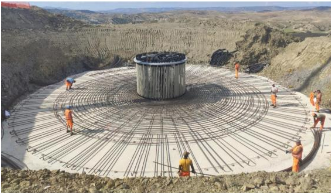
Figura 7 - Posa anchor cages tipo
