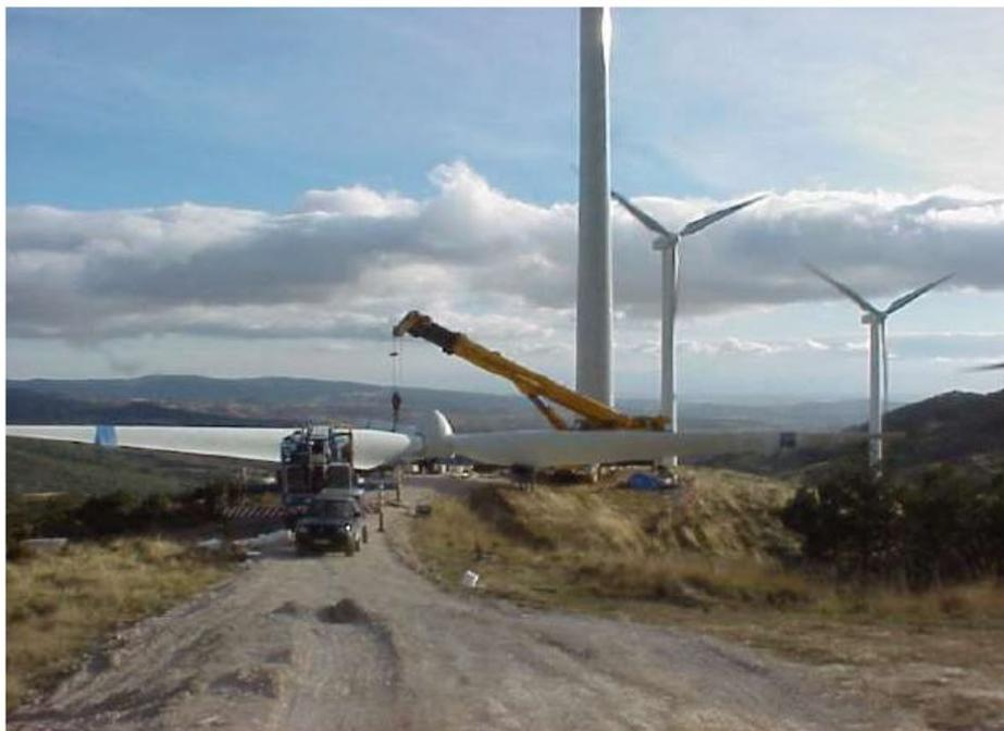
**Figura 4-3: Esempio ingombro del rotore a terra**
